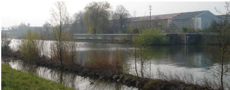
Zicht op de paaiplaats voor vissen, plasberm langs de noordoever van het kanaal ter hoogte van Esser.
