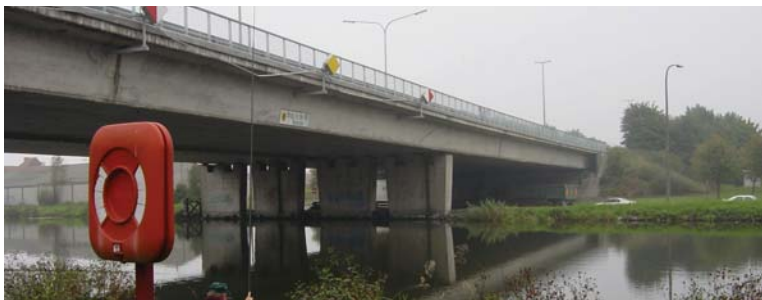
De ringbrug over het kanaal.
