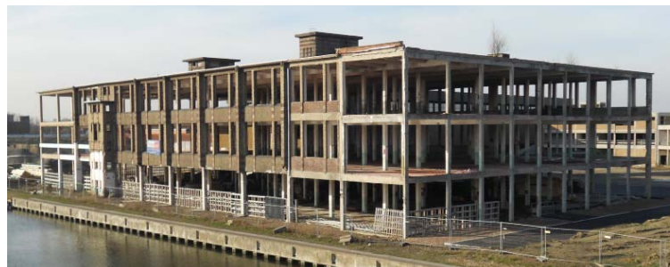
Reconversie van het bedrijvencomplex Kortrijkse Textiel Maatschappij langs het kanaal t.h.v. de Luipaardbrug. Hier is weinig plaats voor de aanleg van een fietspad.
