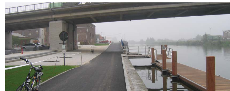
De aanlegsteiger aan het ontmoetingscentrum 'de Brug' in Zwevegem.
