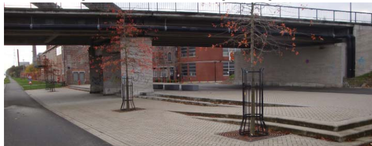
Kwalitatieve aanleg van de kanaaloever aan de Brug in Zwevegem.
