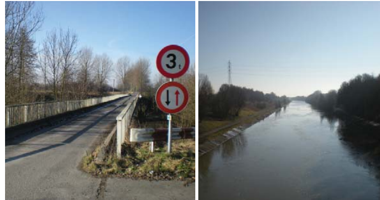
Foto's: smalspoorbrug over kanaal - zicht vanop de smalspoorbrug op de vaarttaluds.
