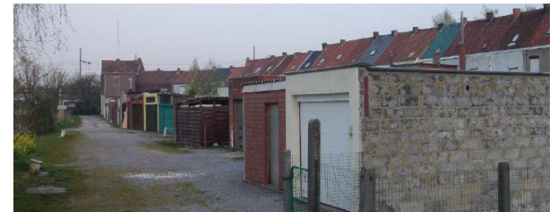
Langs de Stasegemsesteenweg staat een rij van woningen. Aan de achterzijde is dit het beeld langs het kanaal: een rommelig allegaartje van garageboxen.
