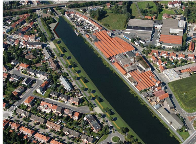
Ter hoogte van het oude seinhuisje werd het nieuwe clubhuis van de Kortrijkse kanoclub gerealiseerd. De groene strook langs de Visserskaai wordt verbreed tot een volwaardige stedelijke parkstrook.
