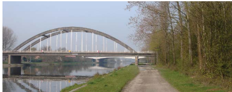
Fietspad op de noordoever ter hoogte tussen Beneluxbrug en de Deerlijkstraat.
